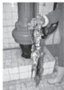
Sie schwimmen an der Oberfläche, verringern dadurch den Sauerstoffaustausch und stören die Biologie der Anlage. Außerdem verstopfen sie Rohrpumpen und Überläufe.
